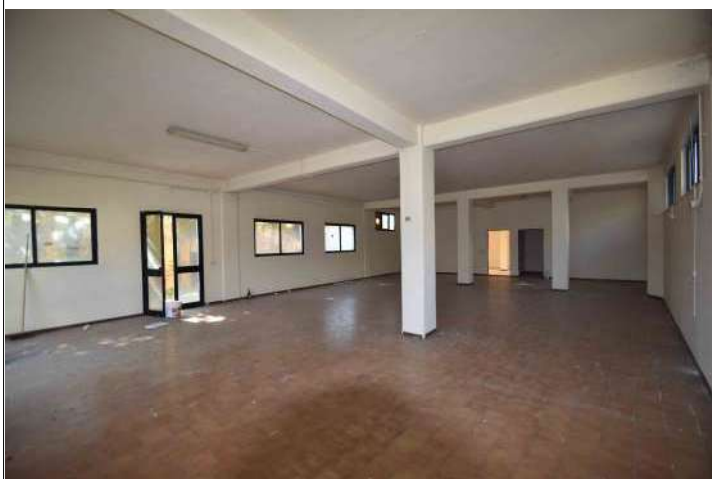
Locale commerciale, vano principale
