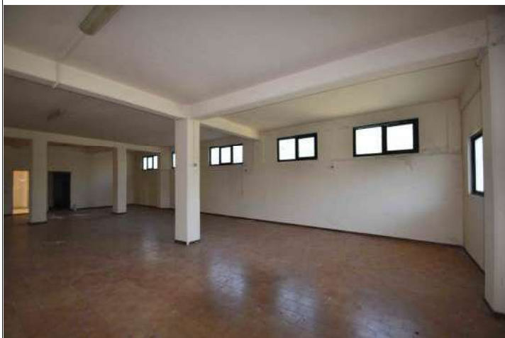
Locale commerciale, vano principale
